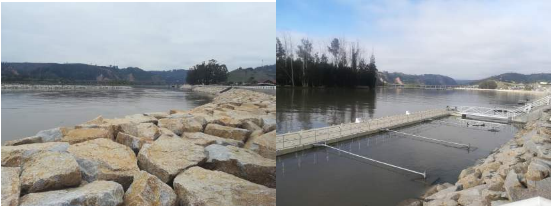
Figura 15: Muro de defensa en la Costanera Borde Río, Constitución.
